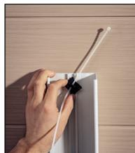
2 Posizionare l'apposita fascetta di fissaggio tubi nello Spifix posto sul binario centrale.
