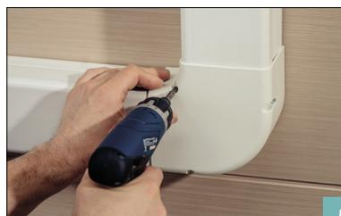
5 Installare i raccordi necessari per completare la linea.
