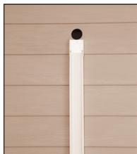
1 Fissare la parte inferiore della canalina Speediduct® al muro (viti di fissaggio non incluse).
