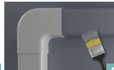
6 Se richiesto, verniciare le canaline per abbinarle al colore del muro sottostante.
