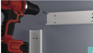
1 Fissare la parte inferiore della Canalsplit® al muro mediante le apposite asole (viti di fissaggio non incluse).
