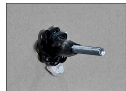
NODO X-TECH SU LASTRA SINGOLA 12,5 MM
