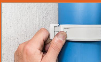
1. Eseguire il foro nel muro e installare il semicollare con il sistema di fissaggio scelto.
